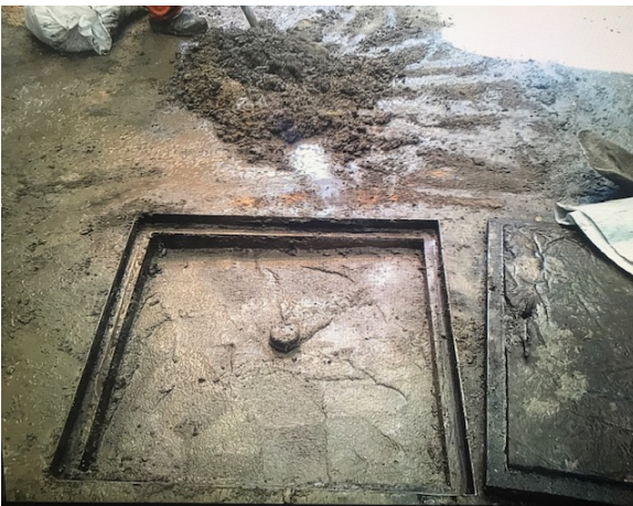
Foto 9. Relleno Cavity pz16-0024
