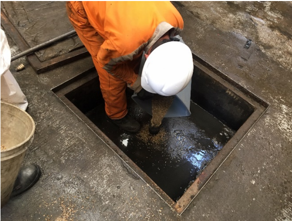
Foto 7. Sellamiento PZ-16-0024 - GRAVA
