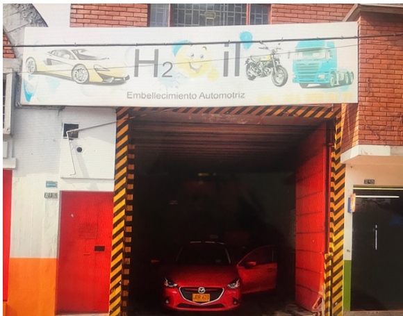
Foto 1. Vista general del predio
