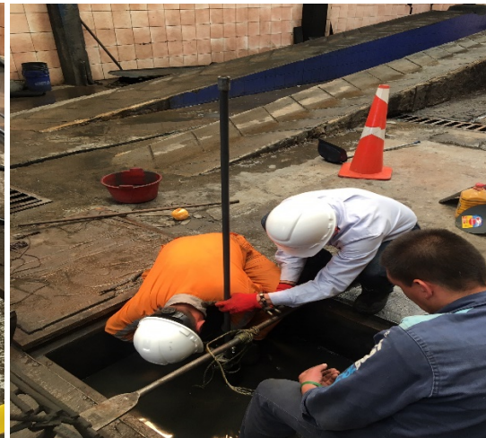
Foto 6. Extracción tubería producción
