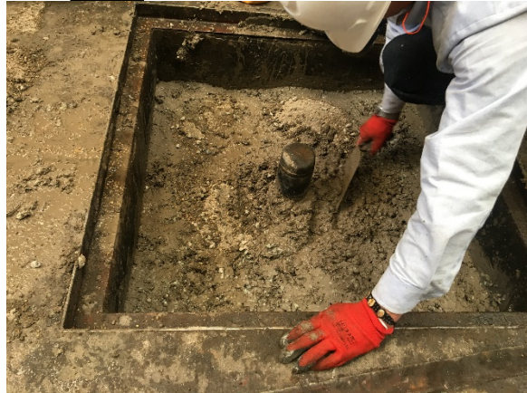
Foto 8. Sellamiento PZ-16-0024 – mezcla
