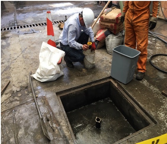
Caja de concreto PZ-16-0024
