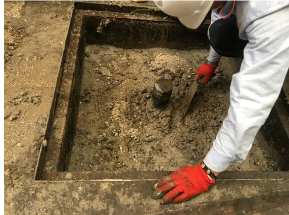
Foto 8. Sellamiento PZ-16-0024 – mezcla
