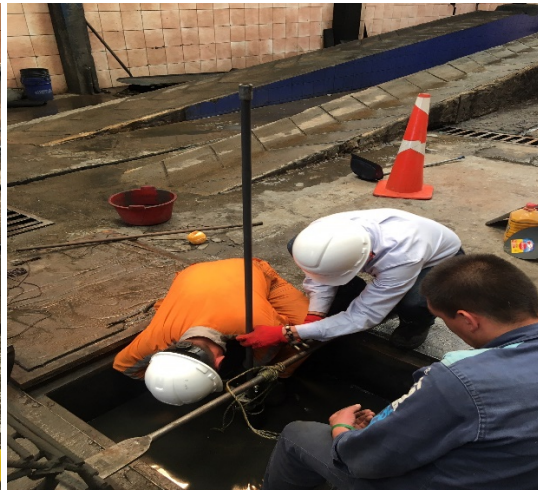
Foto 6. Extracción tubería producción
