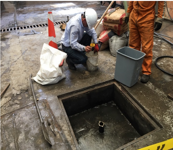
5. Caja de concreto PZ-16-0024
